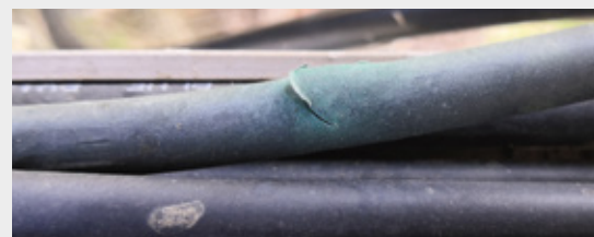
Bild 3: Zerstörte Isolierung
